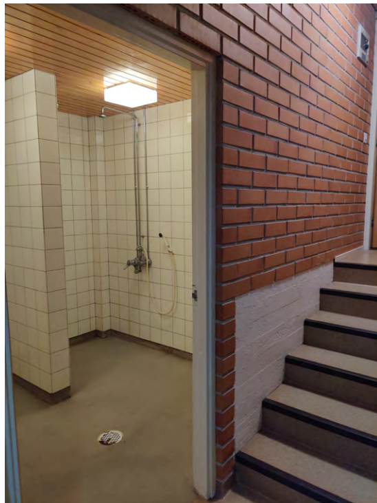
Suihkuhuone 008 ja käytävä 011
