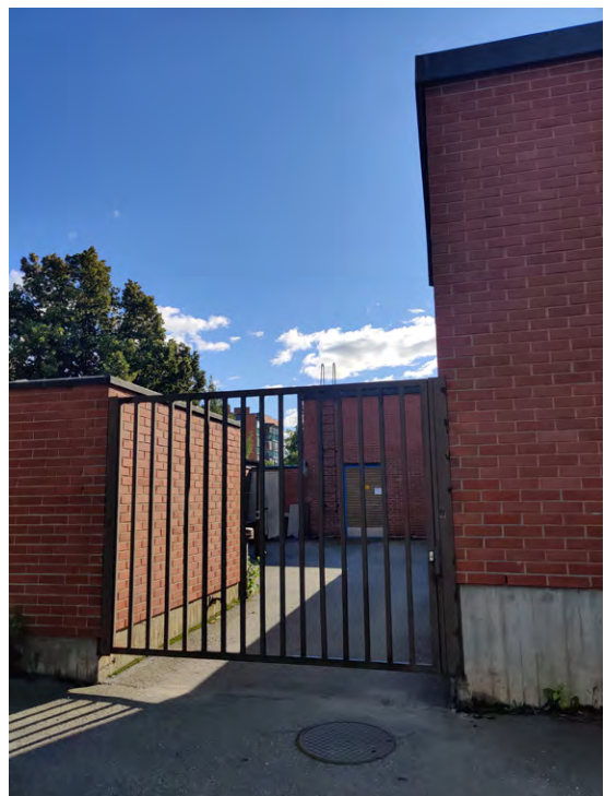
Julkisivu pohjoiseen, huoltopiha
